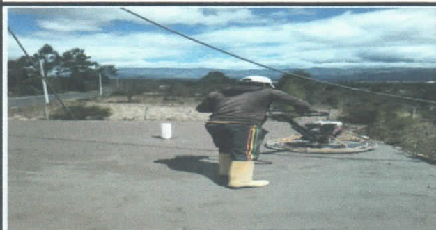
MASILLADO Y IMPERMEABILIZACION DE LA LOSA SUPERIOR
