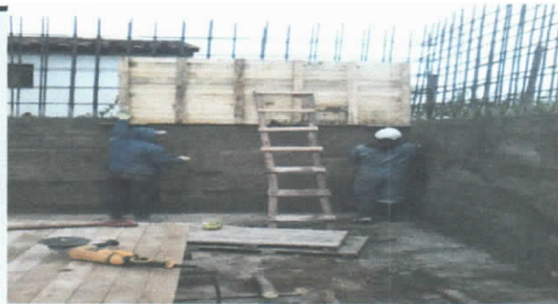
ENCOFRADO DE LAS PAREDES DEL TANQUE DE RESERVA
