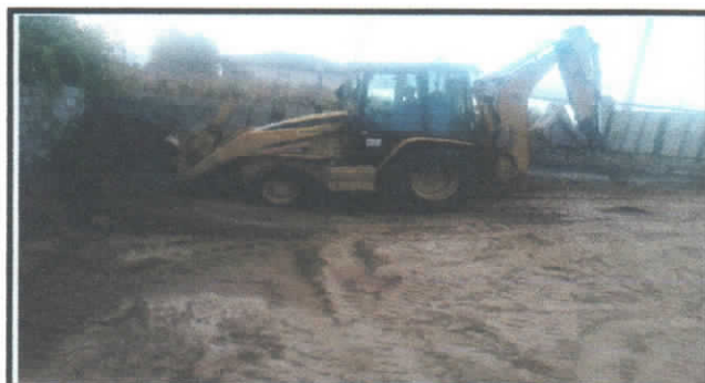
LIMPIEZA DEL TERRENO DONDE SE UBICARA EL TANQUE
