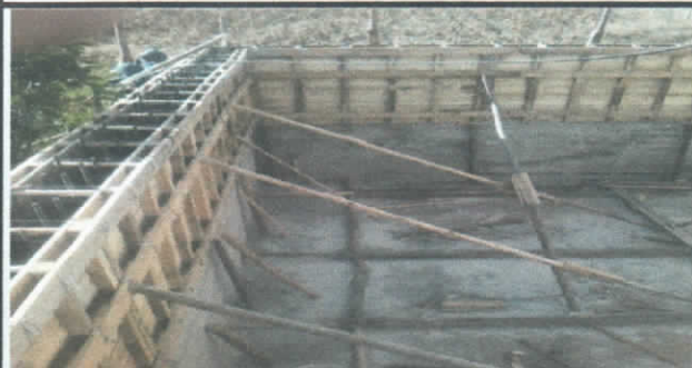
ENCOFRADO DE LAS PAREDES DEL TANQUE DE RESERVA
