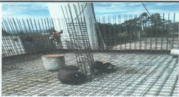
ACERO DE REFUERZO EN LOSA, MUROS, COLUMNA
