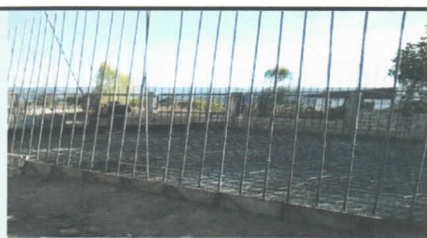
ACERO DE REFUERZO EN MUROS DEL TANQUE
