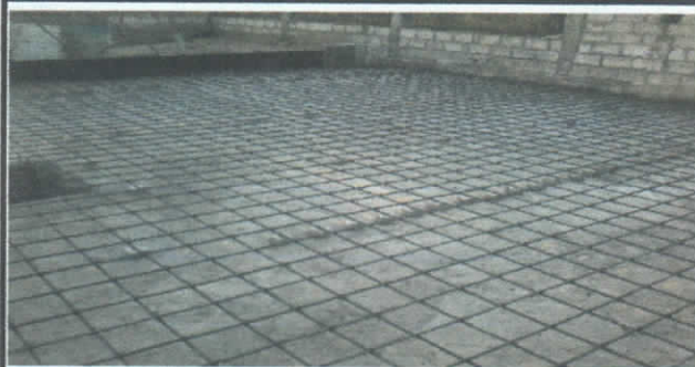
ACERO DE REFUERZO EN LOSA INFERIOR DEL TANQUE DE RESERVA
