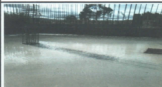
CURADO DEL HORMIGON DE LOSA INFERIOR
