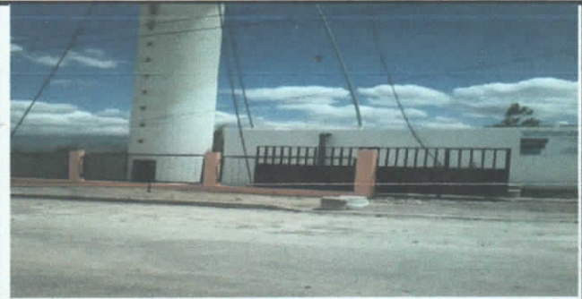
CERRAMIENTO + PUERTA PRINCIPAL DEL TANQUE DE RESERVA
