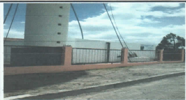
TANQUE DE RESERVA
