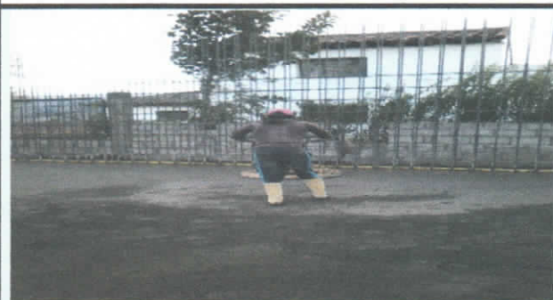
MASILLADO Y ALIZADO DE LOSA DE PISO
