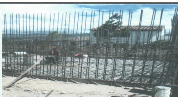
ACERO DE REFUERZO EN MUROS
