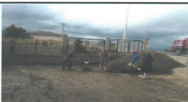
MEJORAMIENTO DEL SUELO Y COMPACTACION
