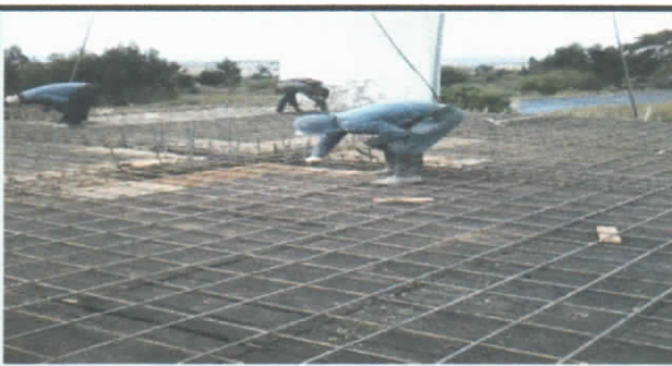
ACERO DE REFUERZO EN LOSA SUPERIOR
