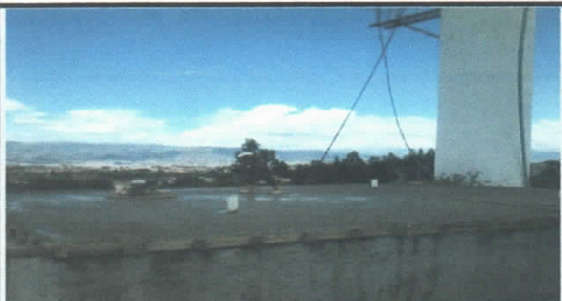
MASILLADO Y IMPERMEABILIZACION DE LA LOSA SUPERIOR
