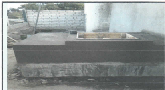
ENLUCIDO, CAJA VALVULA DE SALIDA
