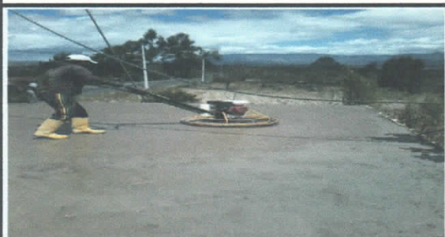
MASILLADO Y IMPERMEABILIZACION DE LA LOSA SUPERIOR
