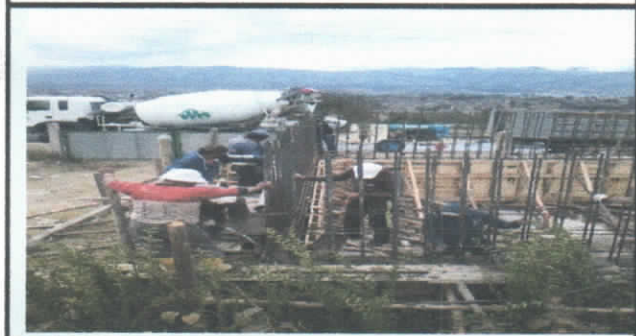
HORMIGONADO DE MUROS DE TANQUE DE RESERVA
