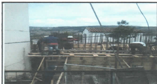
HORMIGONADO DE MUROS DE TANQUE DE RESERVA
