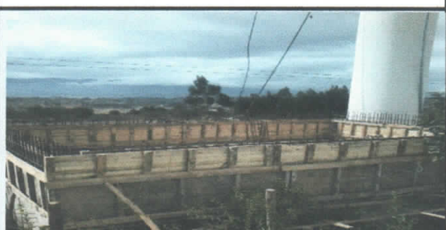
ENCOFRADO DE MUROS DEL TANQUE DE RESERVA
