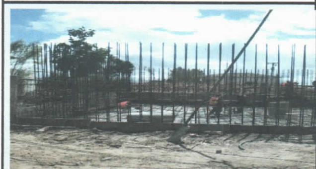
ACERO DE REFUERZO EN LOSA, MUROS
