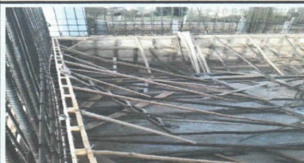
ENCOFRADO DE MUROS DEL TANQUE DE RESERVA
