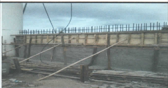
ENCOFRADO DE MUROS DEL TANQUE DE RESERVA
