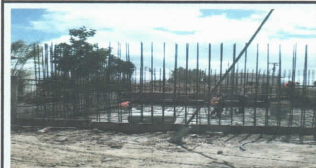
ACERO DE REFUERZO EN LOSA, MUROS
