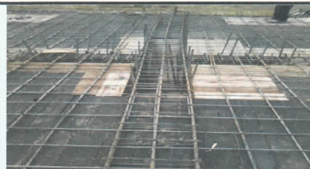
ENCOFRADO DE LOSA SUPERIOR Y ACERO DE REFUERZO EN LOSA Y VIGAS
