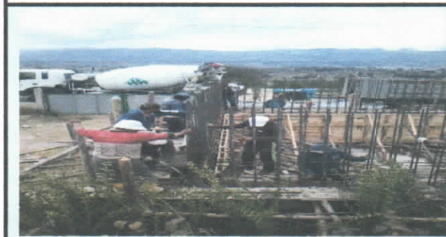
HORMIGONADO DE MUROS DE TANQUE DE RESERVA
