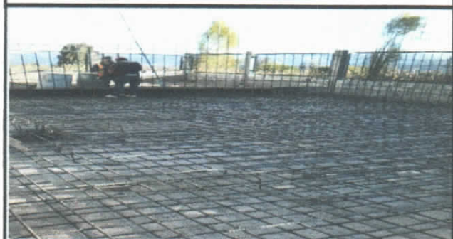
ACERO DE REFUERZO EN LOSA
