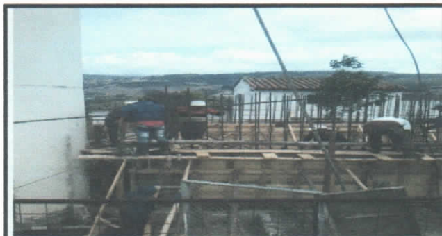
HORMIGONADO DE MUROS DE TANQUE DE RESERVA
