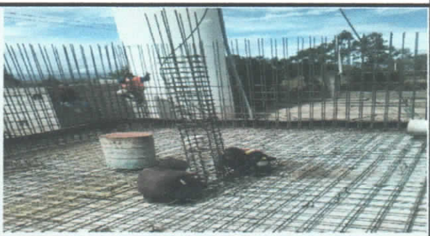
ACERO DE REFUERZO EN LOSA, MUROS, COLUMNA
