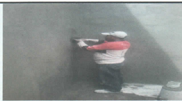
ENLUCIDO + IMPERMEABILIZACION DE LAS PAREDES INTERIORES DEL TANQUE DE RESERVA
