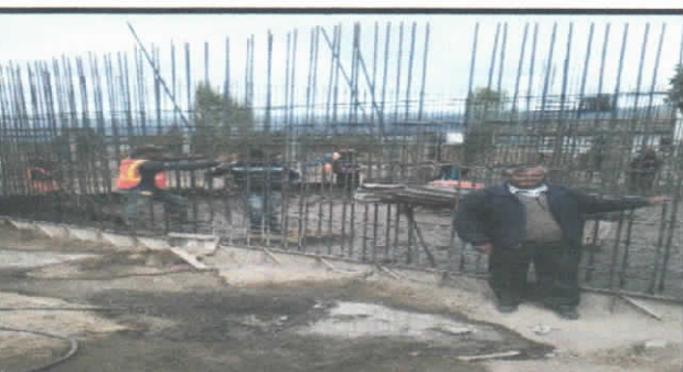
HORMIGONADO DE LOSA INFERIOR DEL TANQUE
