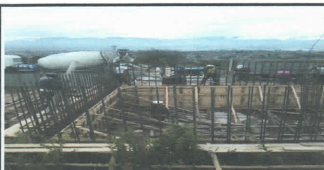
HORMIGONADO DE MUROS DE TANQUE DE RESERVA
