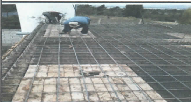
ACERO DE REFUERZO EN LOSA SUPERIOR
