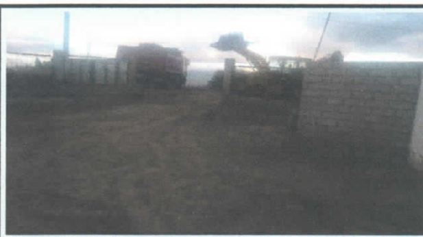
LIMPIEZA Y DESALOJO DE MATERIAL
