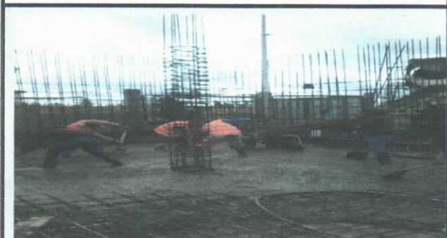
HORMIGONADO DE LOSA INFERIOR DEL TANQUE
