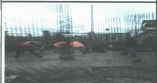
HORMIGONADO DE LOSA INFERIOR DEL TANQUE
