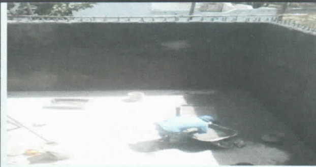
ENLUCIDO + IMPERMEABILIZACION DE LAS PAREDES INTERIORES DEL TANQUE DE RESERVA
