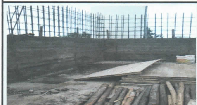
DESENCOFRADO DE MUROS
