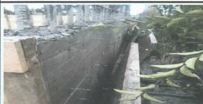
DESENCOFRADO DE MUROS DEL TANQUE DE RESERVA
