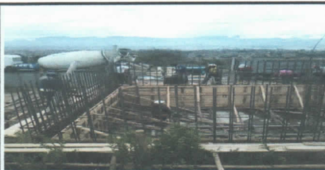
HORMIGONADO DE MUROS DE TANQUE DE RESERVA
