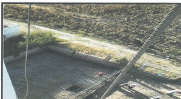
ACERO DE REFUERZO EN LOSA INFERIOR DEL TANQUE
