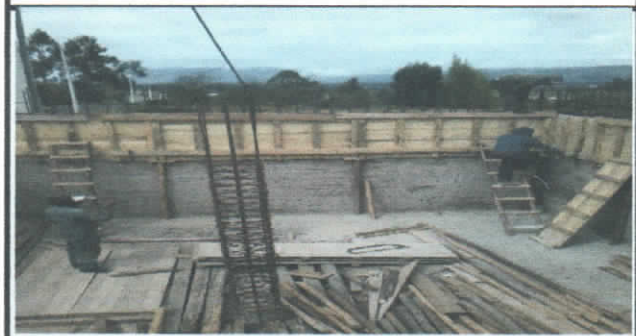
ENCOFRADO DE MUROS DEL TANQUE DE RESERVA
