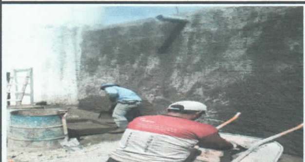
ENLUCIDO EXTERIOR DE LAS PAREDES DEL TANQUE DE RESERVA
