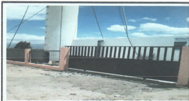
CERRAMIENTO TANQUE DE RESERVA Y PINTURA + PUERTA PRINCIPAL
