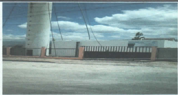
CERRAMIENTO + PUERTA PRINCIPAL DEL TANQUE DE RESERVA
