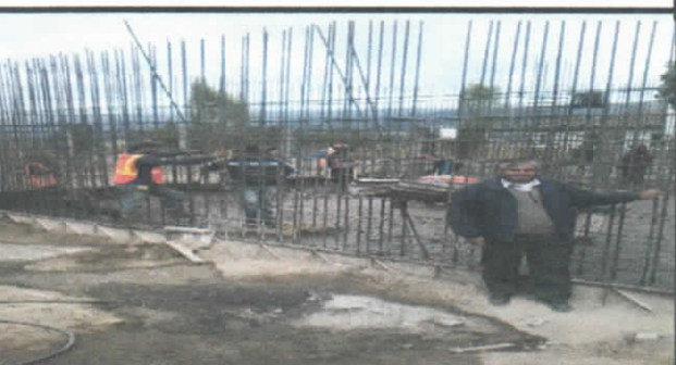
HORMIGONADO DE LOSA INFERIOR DEL TANQUE
