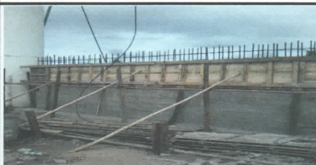
ENCOFRADO DE MUROS DEL TANQUE DE RESERVA
