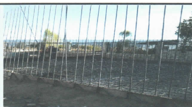
ACERO DE REFUERZO EN MUROS DEL TANQUE
