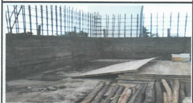
DESENCOFRADO DE MUROS
