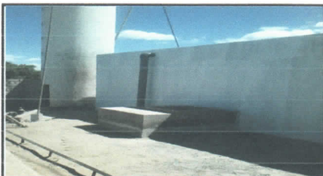
PINTURA EN TANQUE DE RESERVA
