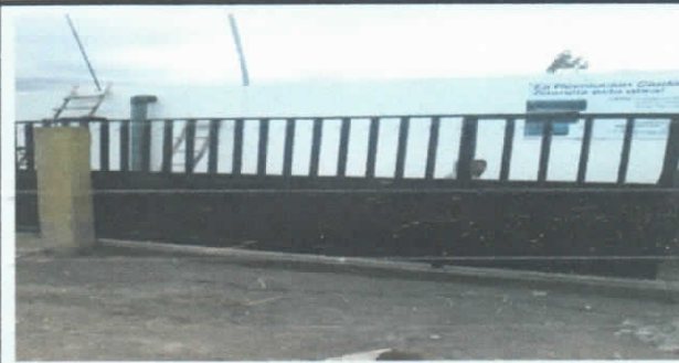
PUERTA CORREDIZA EN CERRAMIENTO DEL TANQUE DE RESERVA
