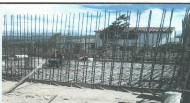
ACERO DE REFUERZO EN MUROS
