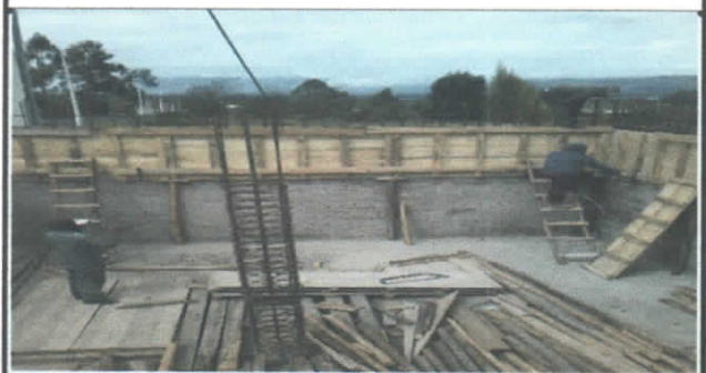
ENCOFRADO DE MUROS DEL TANQUE DE RESERVA
