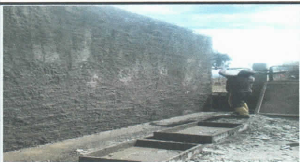
ENLUCIDO EXTERIOR DE LAS PAREDES DEL TANQUE DE RESERVA
