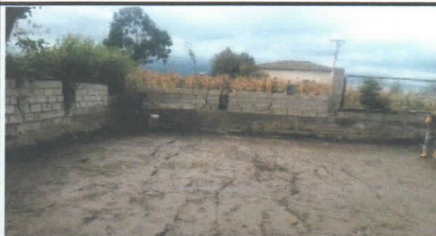
COMPACTACION Y MEJORAMIENTO DE SUELO
