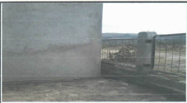
ENLUCIDO EXTERIOR DEL TANQUE DE RESERVA
