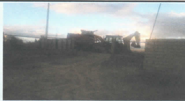
LIMPIEZA Y DESALOJO DEL MATERIAL
