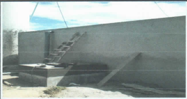
HORMIGONADO DE LOSA INFERIOR DEL TANQUE
