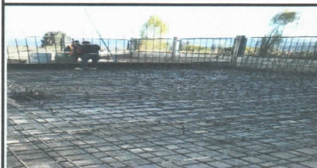
ACERO DE REFUERZO EN LOSA
