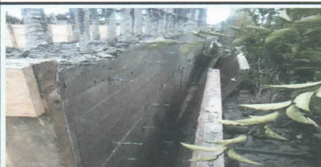
DESENCOFRADO DE MUROS DEL TANQUE DE RESERVA
