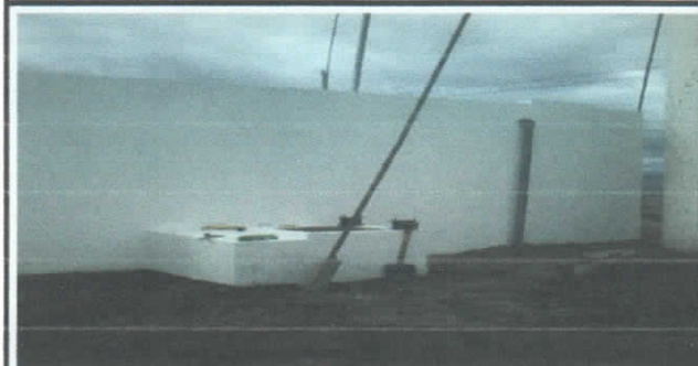
PINTURA EN TANQUE DE RESERVA
