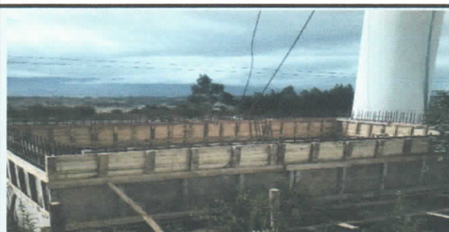
ENCOFRADO DE MUROS DEL TANQUE DE RESERVA
