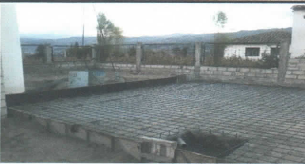
ACERO DE REFUERZO EN LOSA INFERIOR DEL TANQUE DE RESERVA
