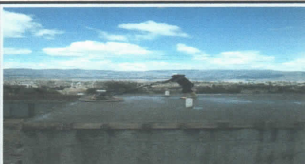
MASILLADO Y IMPERMEABILIZACION DE LA LOSA SUPERIOR
