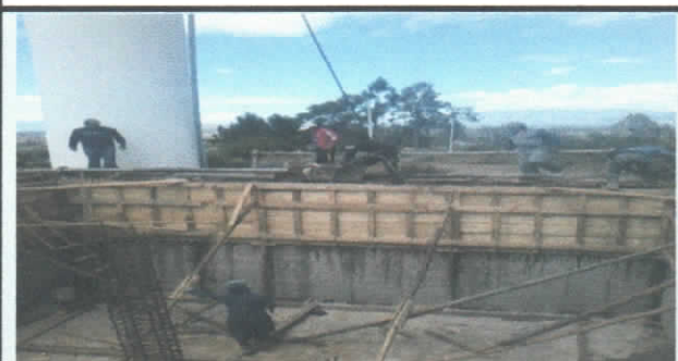
HORMIGONADO DE LAS PAREDES DEL TANQUE DE RESERVA
