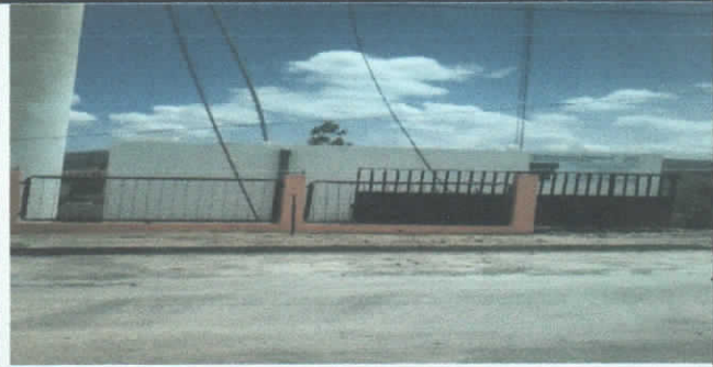
TANQUE DE RESERVA
