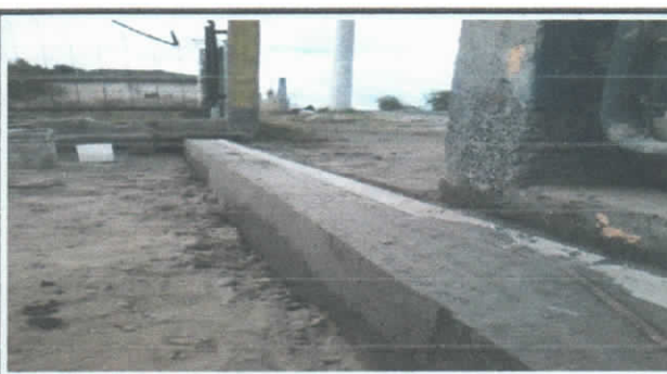
MURO DE HORMIGON CICLOPEO PARA PUERTA CORREDIZA
