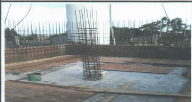
ENCOFRADO DE MUROS DEL TANQUE DE RESERVA
