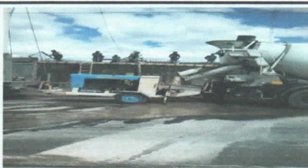
HORMIGONADO DE LOSA SUPERIOR CON HORMIGON PREMEZCLADO
