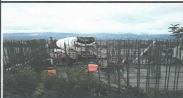
HORMIGONADO DE LOSA INFERIOR DEL TANQUE
