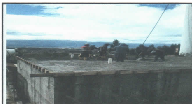
HORMIGONADO DE LA LOSA SUPERIOR CON HORMIGON PREMEZCLADO
