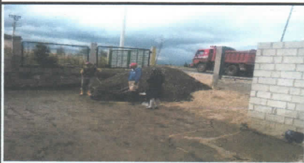
MEJORAMIENTO DEL SUELO Y COMPACTACION
