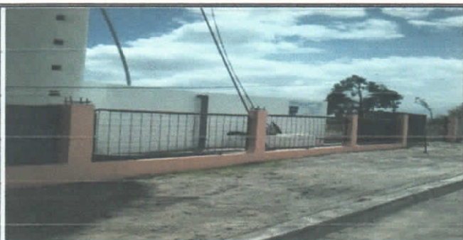
CERRAMIENTO + PUERTA PRINCIPAL DEL TANQUE DE RESERVA
