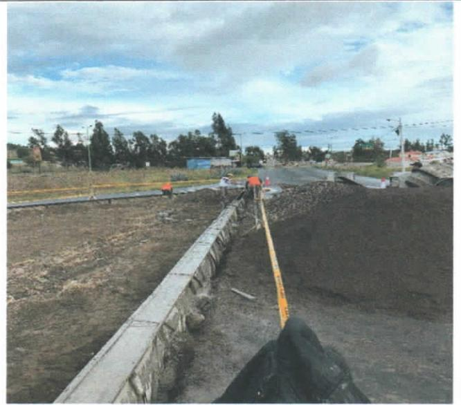
*Ilustración 8 Fundición de bordillos*
