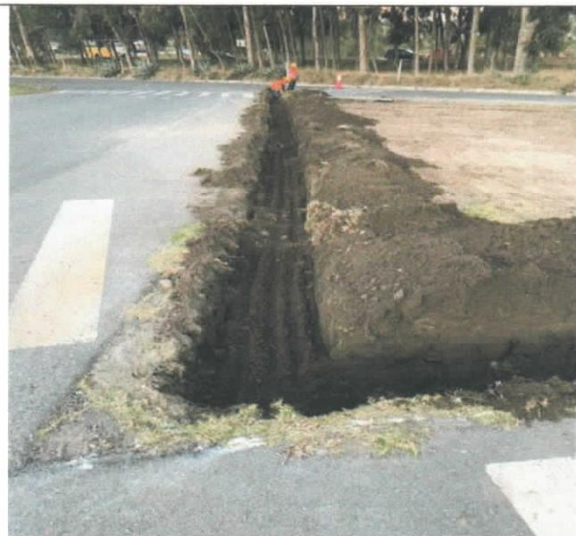
Ilustración 5 Excavación para bordillos
