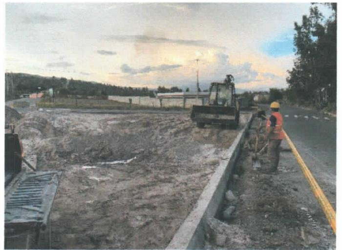
*Ilustración 10 Nivelación y tendido de capa de relleno en el terreno*
