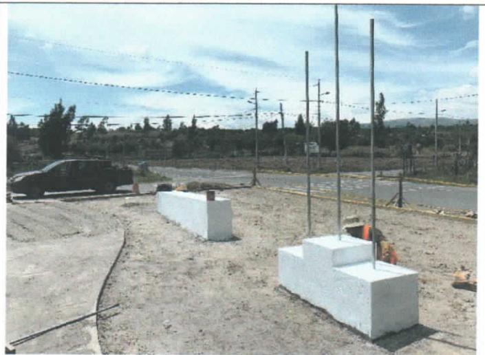
Ilustración 22 Pintura de bordillos, muro y pódium
