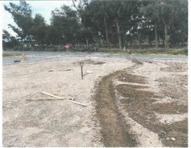
*Ilustración 14 Excavación para pódium, muro y berma de confinamiento de adoquín*
