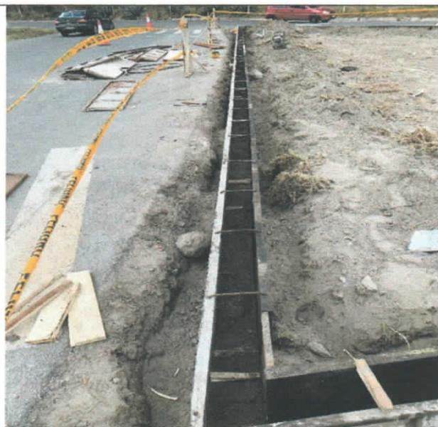
Ilustración 6 Encofrado metálico para bordillos
