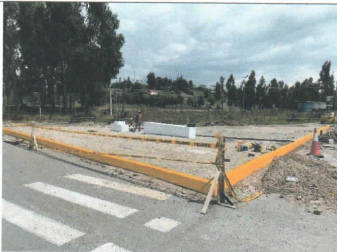
Ilustración 23 Pintura de bordillos, muro y pódium
