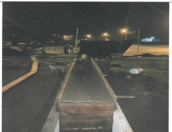
*Ilustración 18 Fundición de berma, pódium y muro*
